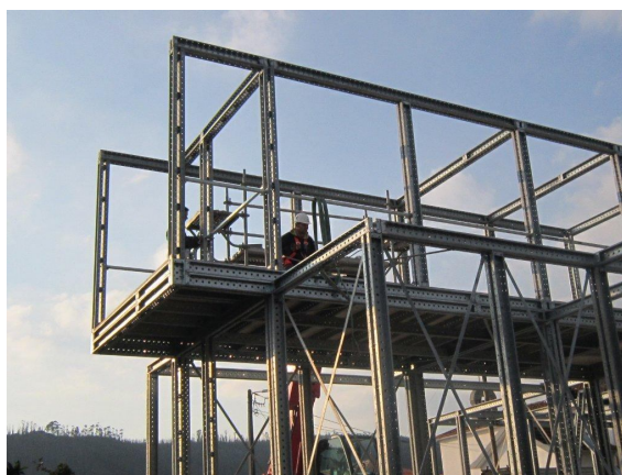
Aspecto do esqueleto estrutural
