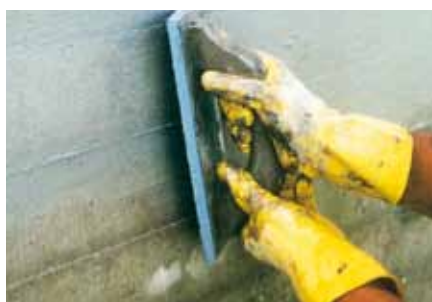
Tendido rascado, aplicado con llana de esponja o de goma dura. Se mantiene la textura del encofrado entablillado.
