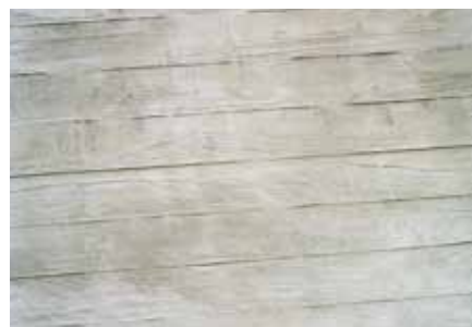
Reproducción de la textura del entablillado en las zonas reparada
