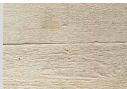
Tendido rascado, aplicado con llana de esponja o de goma dura. Se mantiene la textura del encofrado entablillado.
