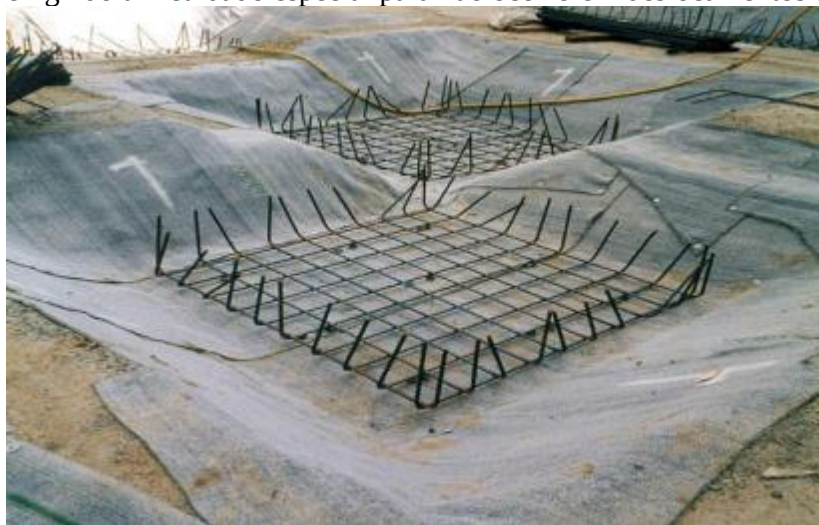
Impermeabilização de uma sapata com membrana bentonítica
