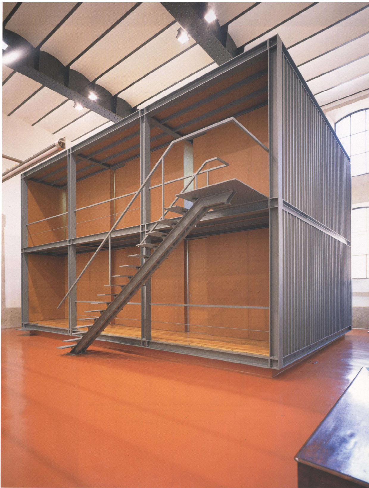
El salón de actos y el box que alberga las oficinas del museo utilizado como prototipo del edificio residencial de la Rua do Teatro en Oporto.
