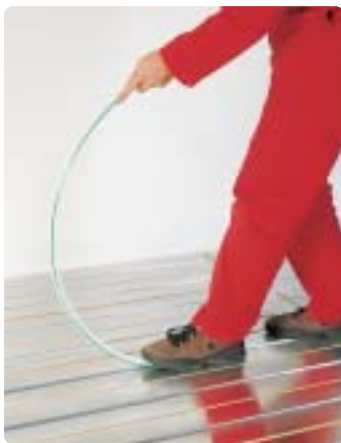
Fig. 2.12 - Traçado de circuitos
