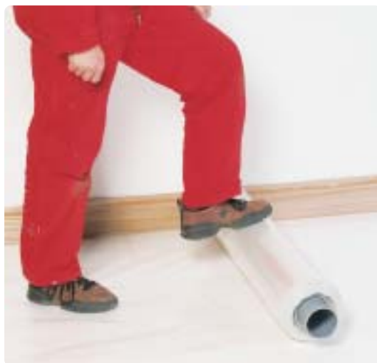
Fig.2.4 - Colocação do filme de PE
