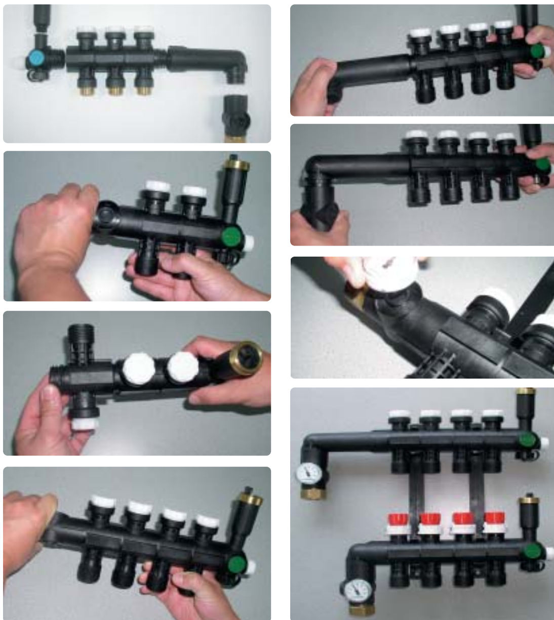
Fig.4.6 - Montagem de um colector de retorno
