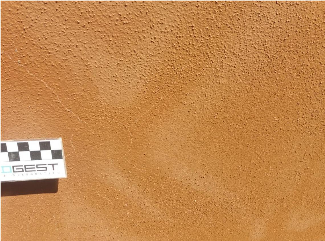
Figura 6 - Micro fissuração
